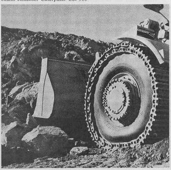
vier Kettengruppen, die jeweils auf ein aufgepumptes Gummirad montiert werden (Bild 1). Bei diesen Rädern handelt es sich nicht um Reifen, sondern um besonders für diesen Zweck konstruierte pneumatische Vorrichtungen. Das Gummirad ist auf ein Spezialrad montiert, welches einen festen Bestandteil der gesamten Gruppe bildet. DK 629.1.032
