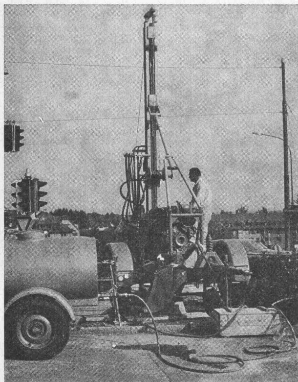
Sondierbohrung Bucheggplatz Zürich
