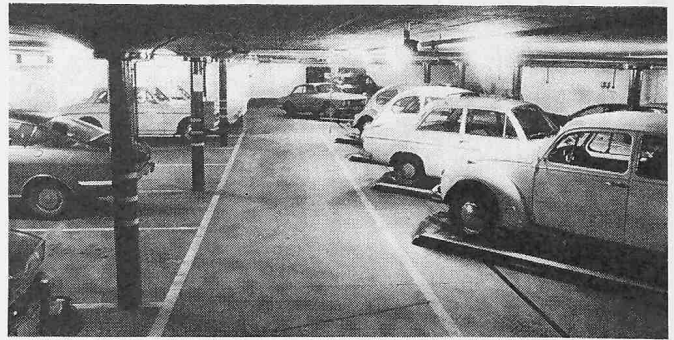
Bild 4. Abfahren. Die Plattform steht mit 45° schräg zur Fahrbahn; es kann vorwärts ausgefahren werden
