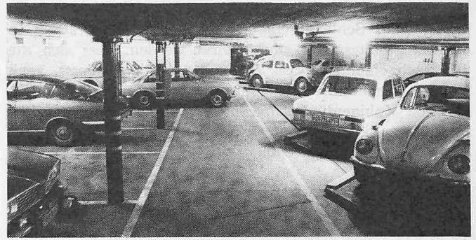
Bild 6. Befahren eines ortsfesten Parkplatzes. Die Plattformen haben sich vor diesem fächerförmig etwa 7 m weit geöffnet
