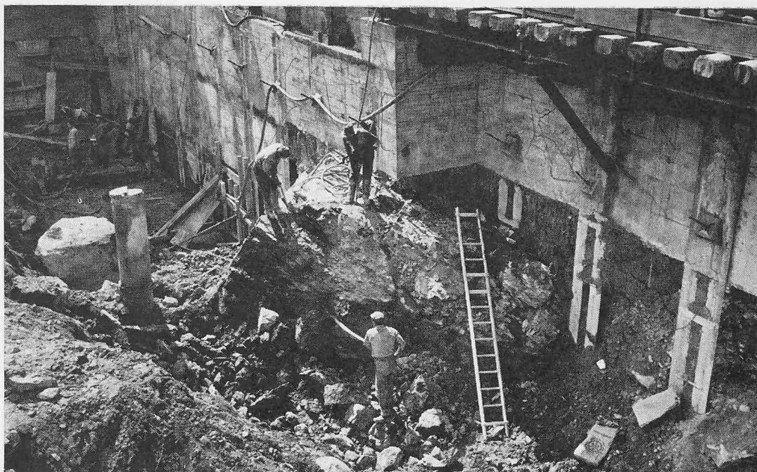
Bild 2. Findling in der Baugrube; Ankerköpfe der oberen Lage der Erdanker
