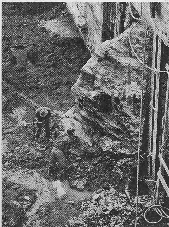
Bild 1. Abbau eines der grössten Findlinge in der Baugrube. Die Rühlwand musste wegen des Findlings unterbrochen werden
