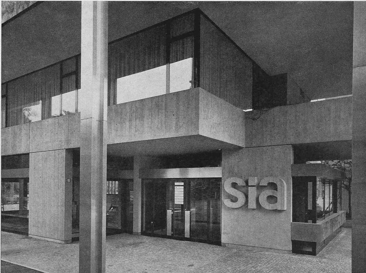
Eingang an der Selnastrasse mit SIA-Emblem von Franz Purtschert. Links das im Ausbau begriffene Restaurant
