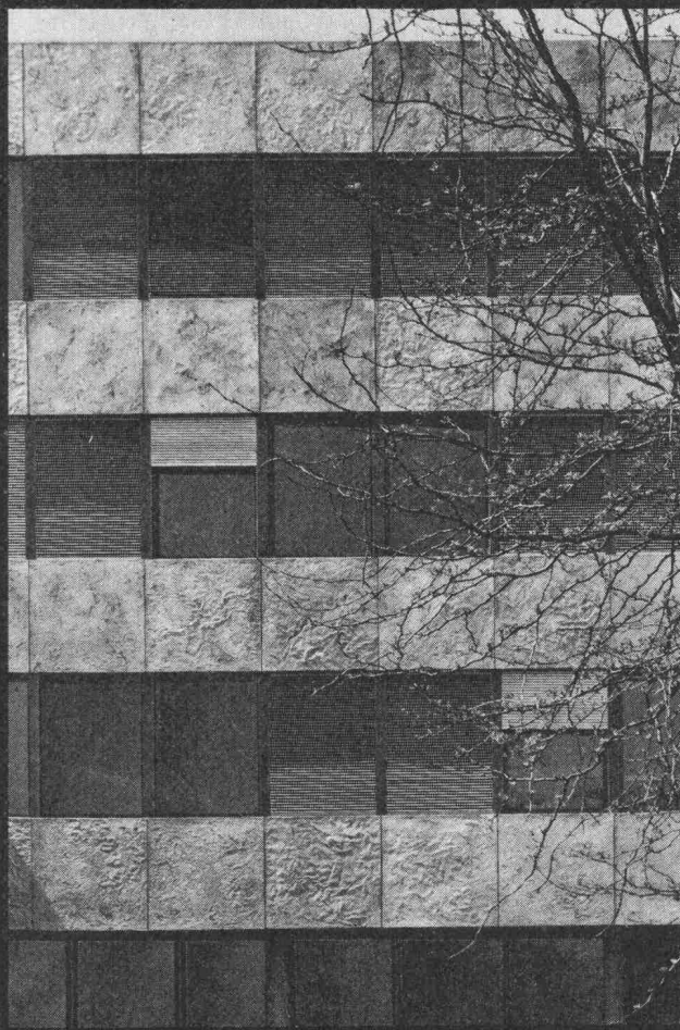
Bürogebäude Bernina, Steckborn
