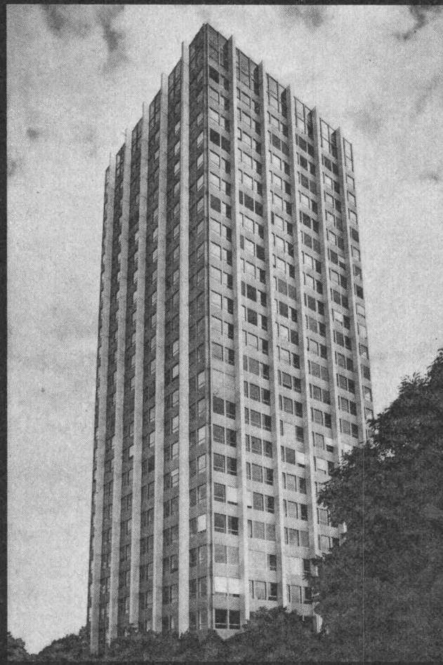
Bürogebäude Sulzer, Winterthur
