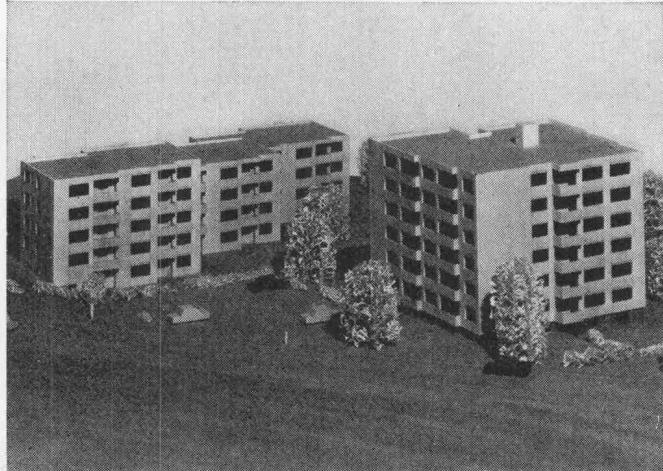
Diese Grossüberbauung wird vollelektrisch beheizt. Technische Daten: Anzahl Wohnungen: total 68; Anschlusswert der Heizanlage: ca. 500 kW; Ausrüstung: Star Unity-Nachtstrom-Wärmespeicher, Star Unity-Nieder-temperatur-Strahlungsheizung; Steuerung: vollautomatisch, aussen- und innentemperaturabhängig.
