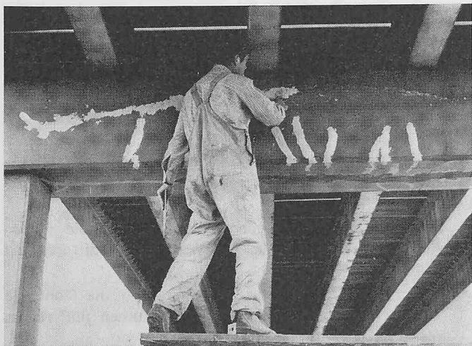
Anbringen der Oberflächenversiegelung als Vorbereitung für die Fugeninjektionen mit Epoxy-Harz
