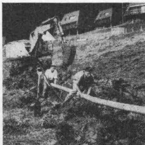
Kanalisation Schwyz: Rothenturm
