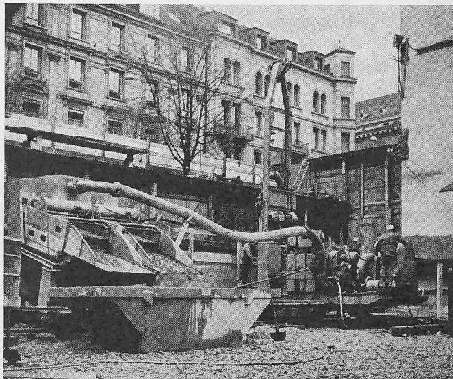
Baugrube mit Schlitzwand Seite Bahnhofstrasse. Sichtbarer Teil der Verankerungseisen, darunter Bohrmaschine (Atlas Capco) für Anker der Swissboring
