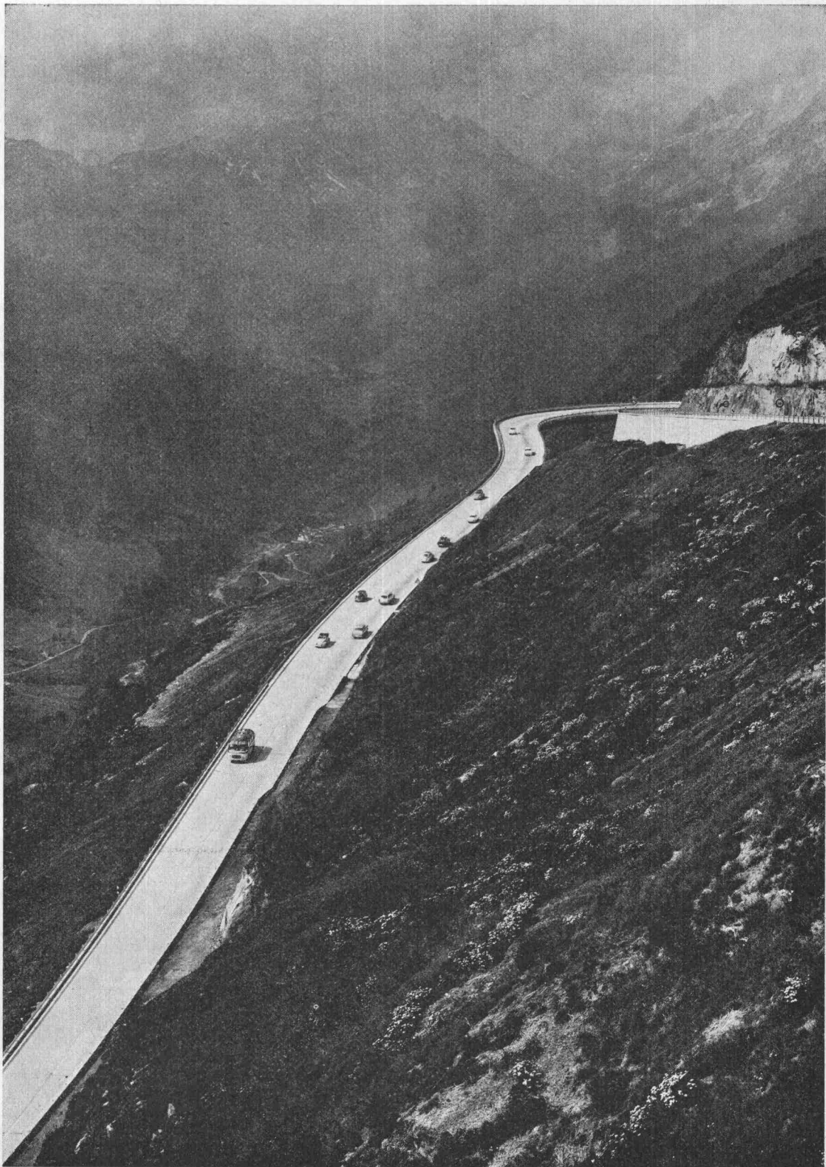
Nationalstrasse N 2, Gotthard-Südrampe, Betonbelag
