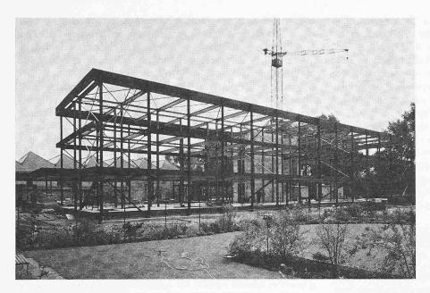
Bild 2. Fertiggestellte Tragkonstruktion aus Stahl
