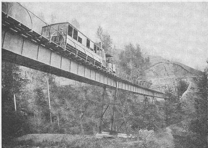
Bild 4. Schnurtobelbrücke im Originalzustand. Dampflokomotive mit stehendem Kessel
