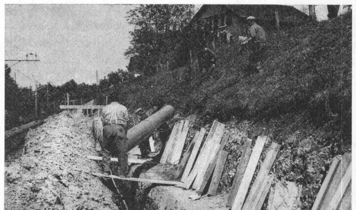
KALIDUR-Kanalisationsrohre, verlegt im Bahneinschnitt
