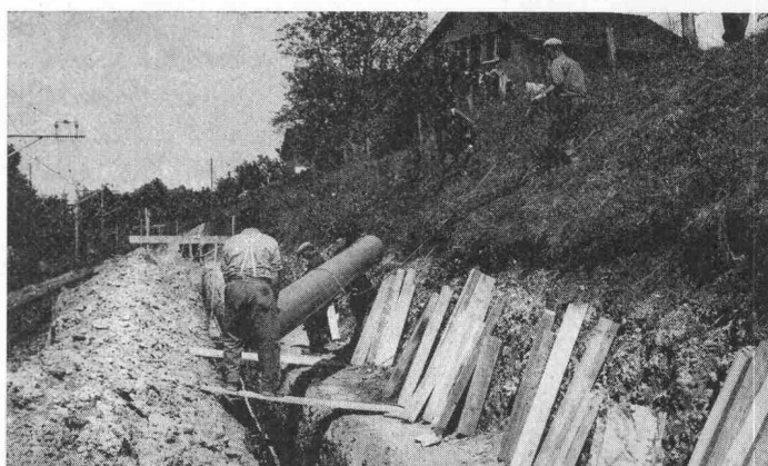
KALIDUR-Kanalisationsrohre, verlegt im Bahneinschnitt
