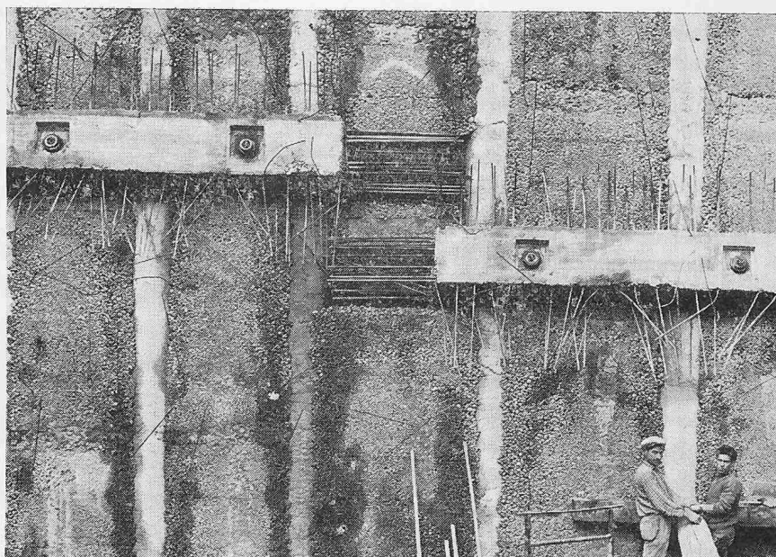
Bild 16. Rühlwand (Baustelle BBC, Baden)
