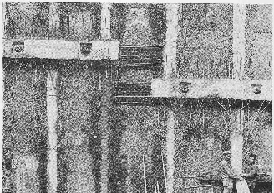
Bild 16. Rühlwand (Baustelle BBC, Baden)
