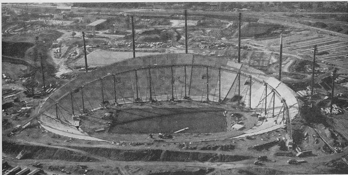
Bild 7. Hauptstadion im Bauzustand, November 1970, vom Fernsehturm aus gesehen. Die Massivbauarbeiten (Statik und Konstruktion: dipl. Ing. H. Isler, Burgdorf, in Zusammenarbeit mit Dipl.-Ing. H. J. Cordes, München) sind zur Hauptsache bereits abgeschlossen. Auf der Hilfskonstruktion in Bildmitte wird das grosse Randkabel gesponnen. Nach der Verspannung des Daches werden die Fachwerkträger und Stahlstützen wieder entfernt. Hinter dem Stadion stehen die Pylone der Überdachung, die aus der Vertikalen noch in die endgültige Lage geschwenkt werden müssen
