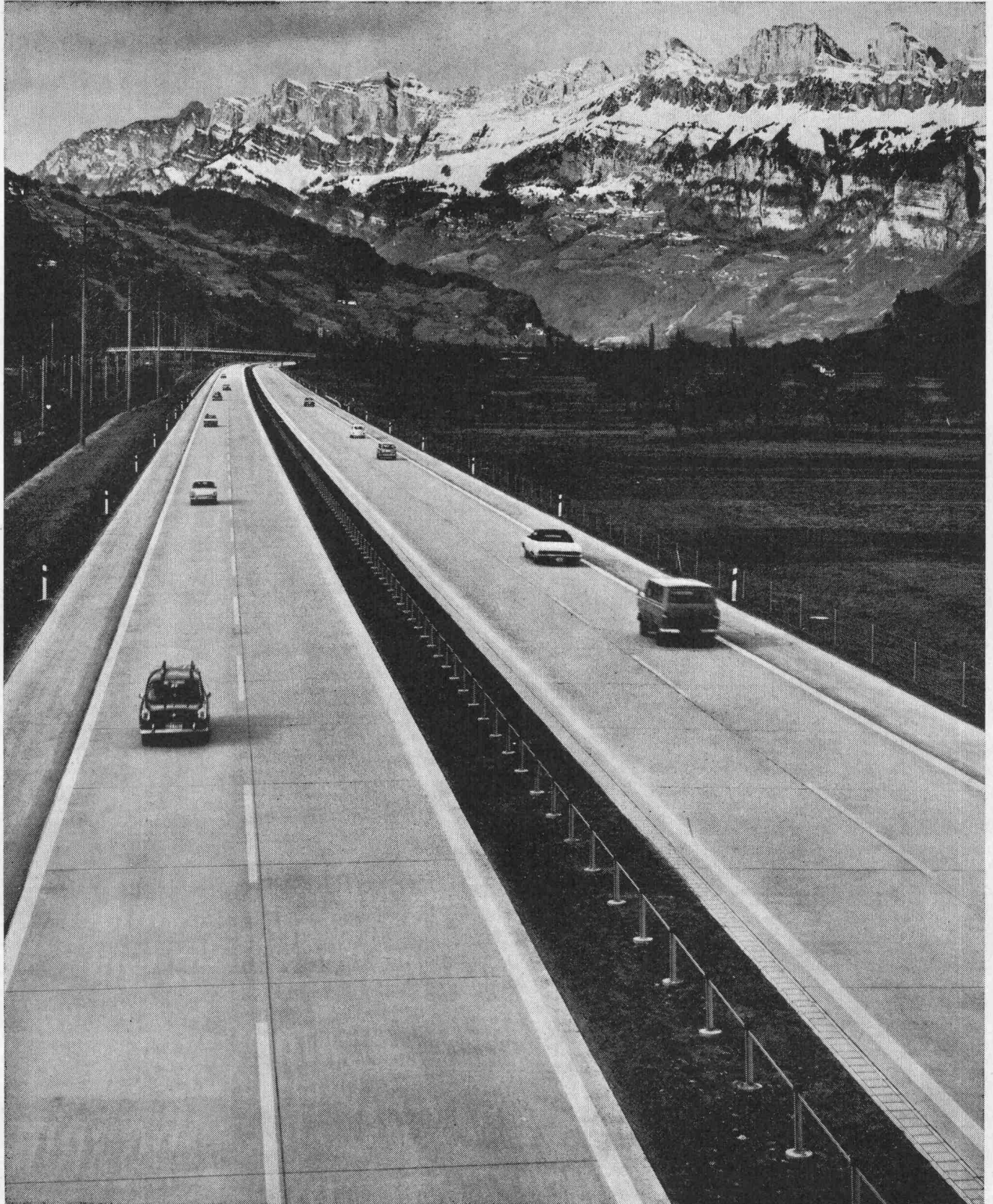
Nationalstrasse N 3 Zürich—Chur, Teilstrecke Flums—Mels, Betonbelag
