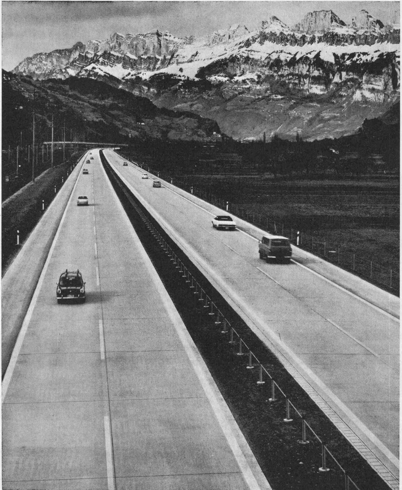
Nationalstrasse N 3 Zürich—Chur, Teilstrecke Flums—Mels, Betonbelag
