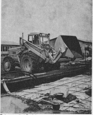
Er transportiert Fertigbeton und Kies.
