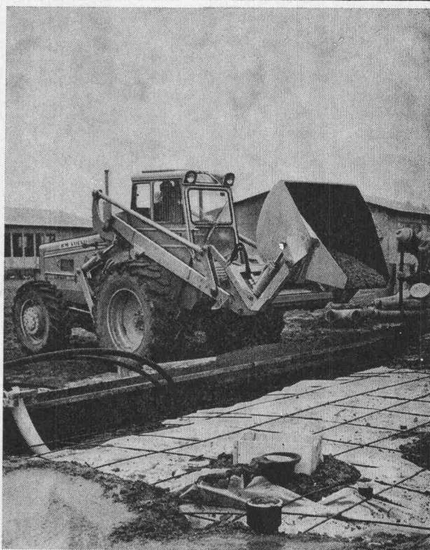
Er transportiert Fertigbeton und Kies.
