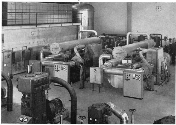
Ölfreie Kälteanlage in einem chemischen Produktionsbetrieb in der Schweiz mit zwei Uniturbo-Kälteanlagen mit zweistufiger Expansion und einer Kälteleistung von je 1,3 Mio kcal/h, zur Abkühlung von Sole von  $-10^{\circ}$  auf  $-14^{\circ}$ C. Im Vordergrund 5 einstufige und 4 zweistufige Labyrinthkolben-Kompressoren für die Erzeugung von Kälte für verschiedene Zwecke bei Verdampfungstemperaturen von  $-60^{\circ}$ ,  $-48^{\circ}$  und  $-36^{\circ}$ C.
