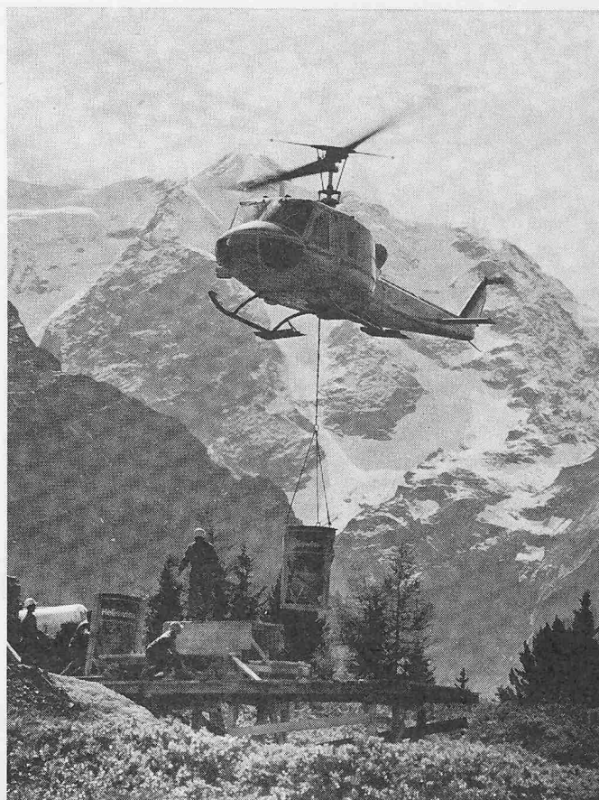
Der Hubschrauber Augusta Bell 204B bei der Versorgung einer Baustelle mit Frischbeton
