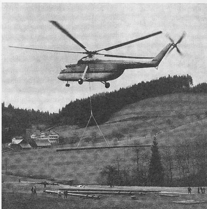
Der Grosshelikopter MI 6 beim Transport von Betonmasten. Die Maschine hat eine Tragkraft von 8 Mp
