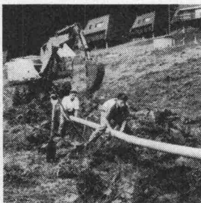
Kanalisation Schwyz: Rothenturm
