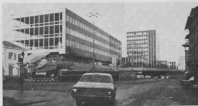
Bild 1. Gesamtansicht der Berner Bahnhofneubauten (Standpunkt Heiliggeistkirche); Vordergrund Ostflügel des Kopfbaues, Mitte Dienstgebäude Bollwerk Süd mit Turmbau, rechts Hotel Schweizerhof
