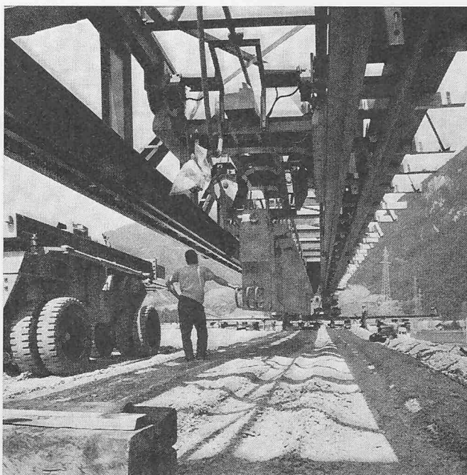
Bild 4. Längsträger unter dem Versetzgerüst
