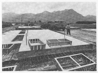
Bild 7. Vorfabrikation der Fahrbahnplatten
