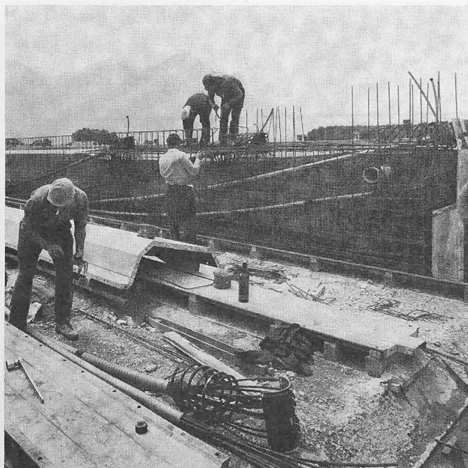
Bild 3. Vorfabrikation der Längsträger
