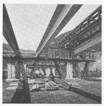
Bild 9. Längsträger beim Versetzen
