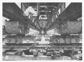
Bild 5. Untersicht Versetzgerüst
