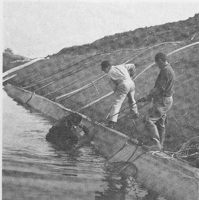
Bild 14. Anwendung von Dichtungsmatten in Belgien
