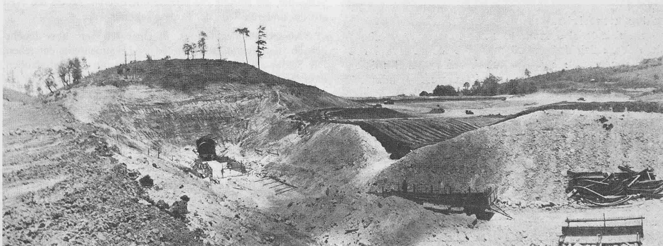
Bild 4. Baustelle am Wasserkraftwerk Rio Lindo in Honduras
