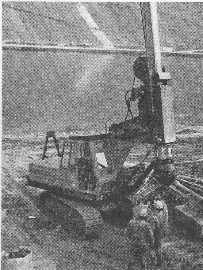
Bild 1. JCB-Bagger Typ 7C mit angebauter Tiefschachteinrichtung
