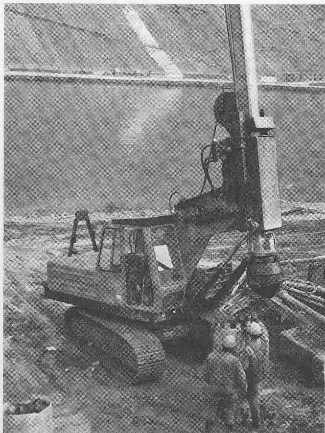
Bild 1. JCB-Bagger Typ 7 C mit angebauter Tiefschachteinrichtung
