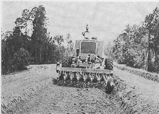
Bild 4. Die heckmontierte Scheibenegge lockert, zerkleinert und mischt das Material
