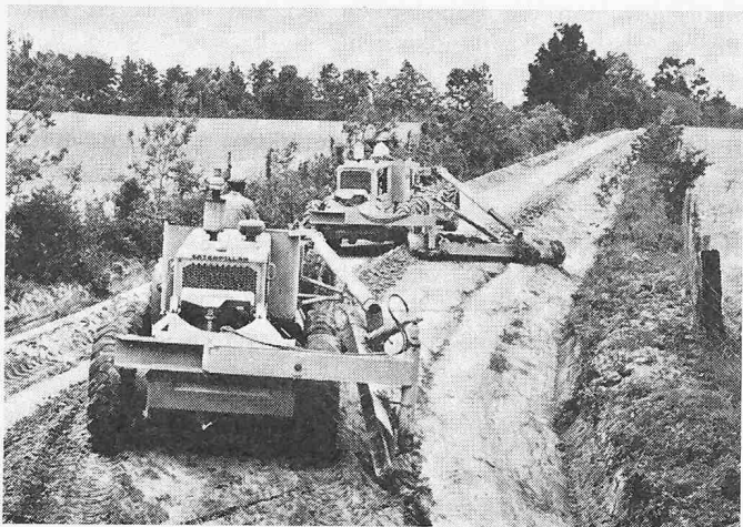
Bild 3. Mit dem Böschungsebner können feuchte und trockene Gräben angelegt und gereinigt werden
