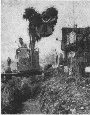
Arbeit mit dem Grabenlöffel
