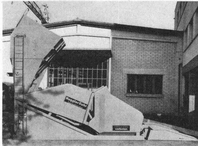
Bild 2. Huggler-Doppelumschlaggerät mit zwei Mulden
