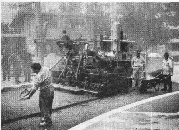
Bild 1. Blaw-Knox-Schwarzbelag-Einbaumaschine Modell PF-90 DV, mit kombiniertem Stampf- und Vibrations-Einbaubalken, fugenlose Einbaubreite bis 6 m
