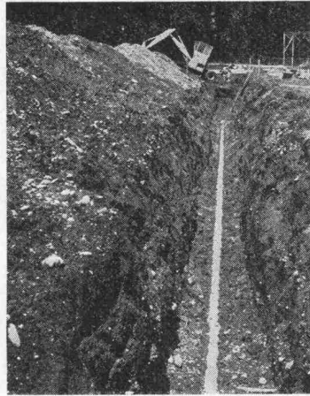
Graben für eine Rohrleitung
