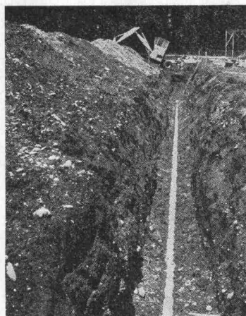
Graben für eine Rohrleitung
