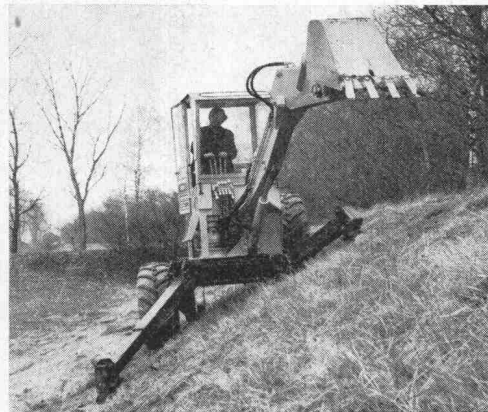
Der Bagger ist bereit für die Arbeit am Hang
