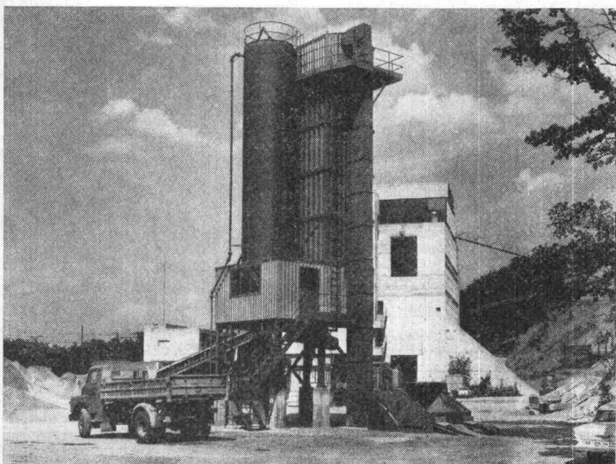
Bild 1. Ammann-Betonzentrale BZT-500/1000. Leistung 35 bzw. 60 m 3 /h
