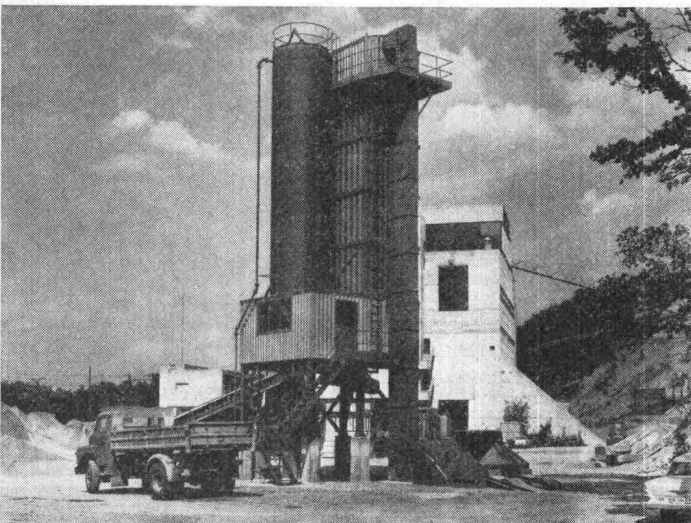
Bild 1. Ammann-Betonzentrale BZT-500/1000. Leistung 35 bzw. 60 m 3 /h
