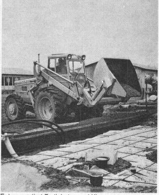
Er transportiert Fertigbeton und Kies.
