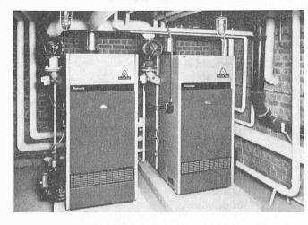
Heizzentralen mit mehreren Kesseln notwendigen einzelnen Kamine entfallen. Nach DIN 4751 Blatt 2 (geschlossene Anlagen) können Zentralheizungsanlagen auch als geschlossene Anlagen ausgeführt werden, wenn das zu beheizende Objekt höher als 15 m ist, sofern der entsprechende statische Druck am tiefsten Punkt des Wärmeerzeugers nicht überschritten wird.
