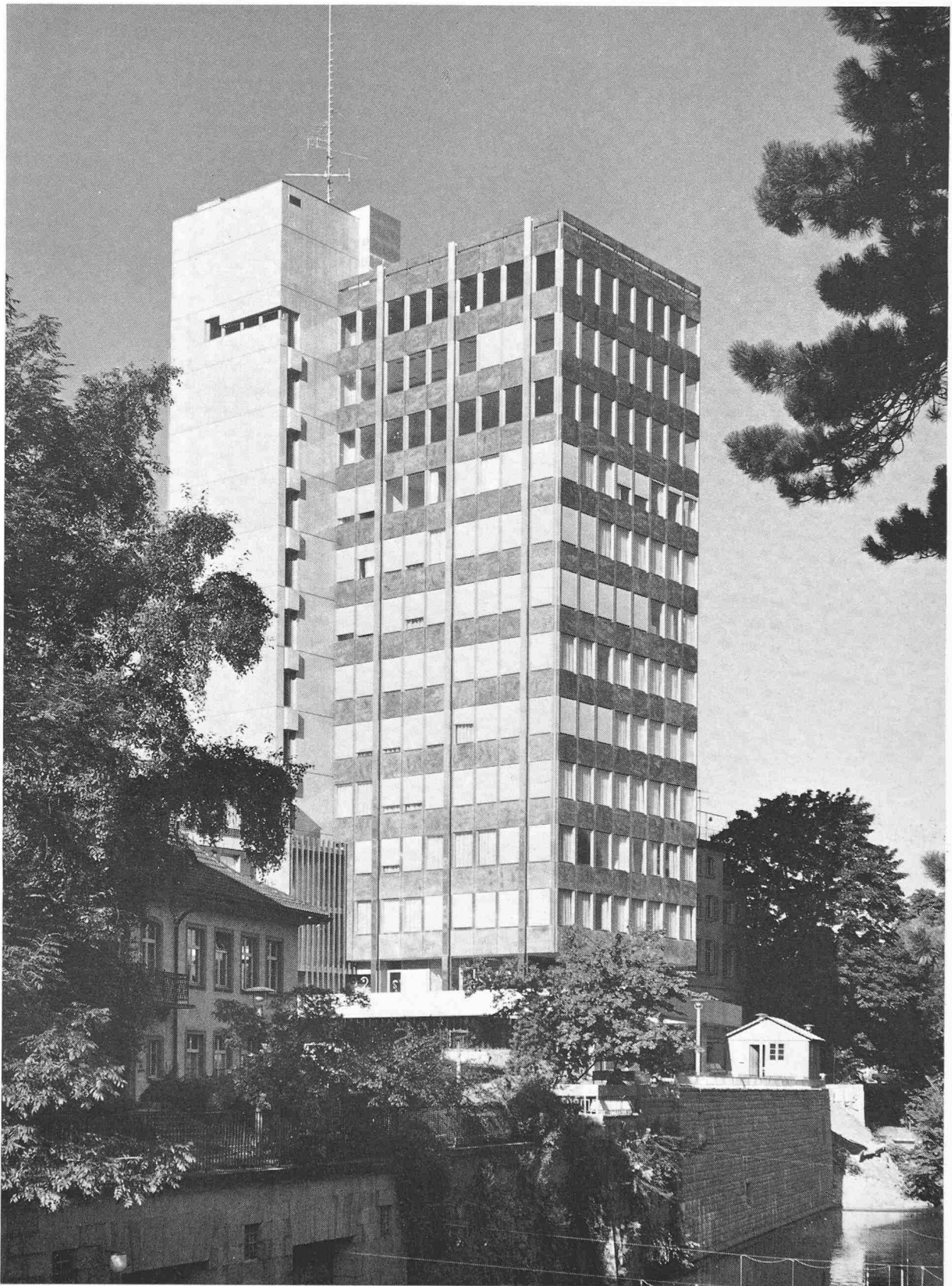
Ansicht aus Osten, vorn der Schanzengraben
