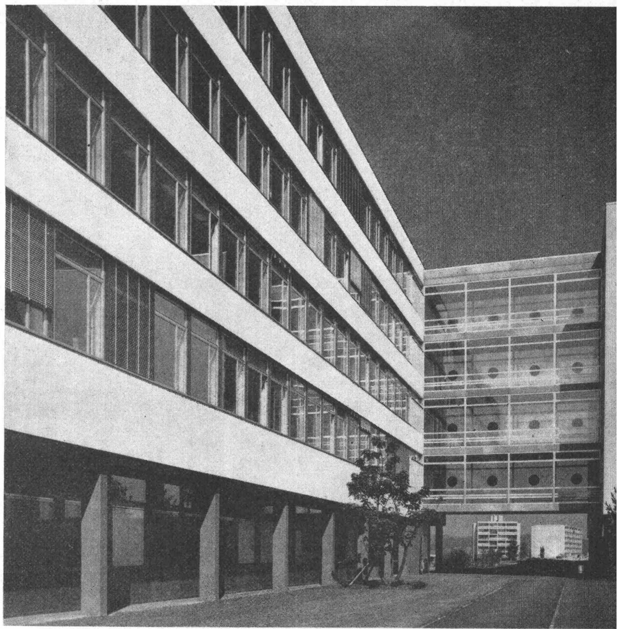
BBC AG Baden / Werk Birrfeld / Lieferung von 2700 m<sup>2</sup> Leichtmetallfenstern und Fassadenkonstruktionen für
