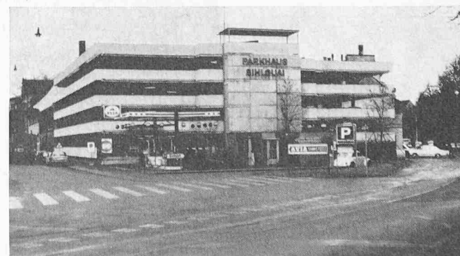
Bild 2. Beispiel Parkhaus Sihlquai, Zürich. Vorfabrizierte Bauteile. Kosten pro Standplatz rund 7500 Fr.
