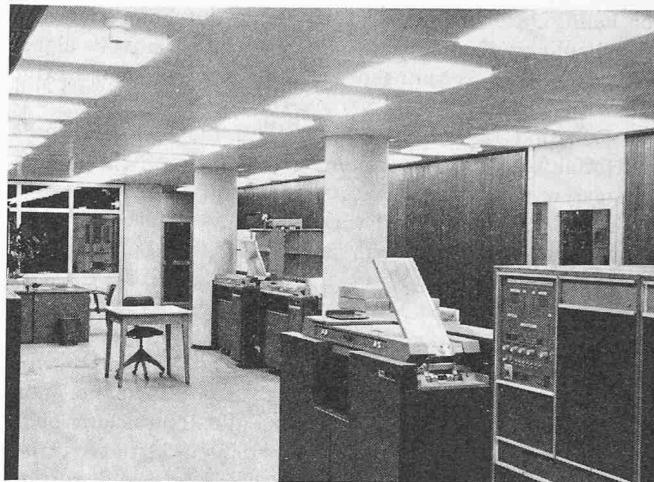
Bild 15. Computerraum mit «Unipro»-Montagedecke. Die Metallplatten sind mit Schnappverschlüssen an den Profilen der Unterkonstruktion befestigt
