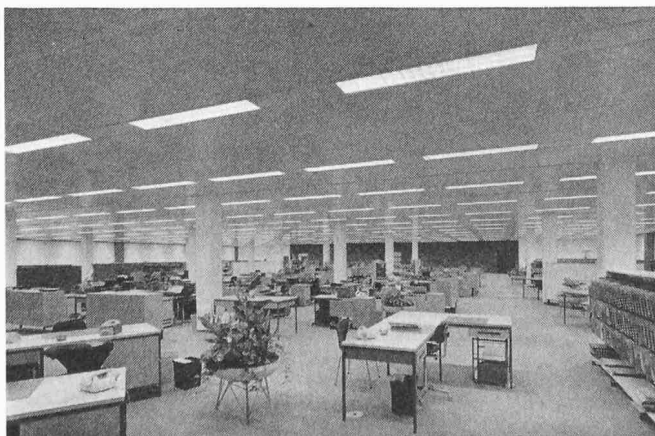
Bild 12. Grossraumbüros mit «Unipro»-Montagedecke in Einlegemontage. Die Luft wird durch Schlitzdiffusoren eingeblasen und durch die Leuchten abgesaugt
