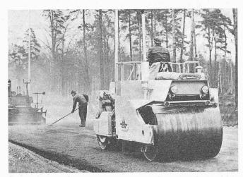
Bild 1. Die Vibrationswalze *Dynapac CC-40* der AB Vibro Verken im Einsatz
