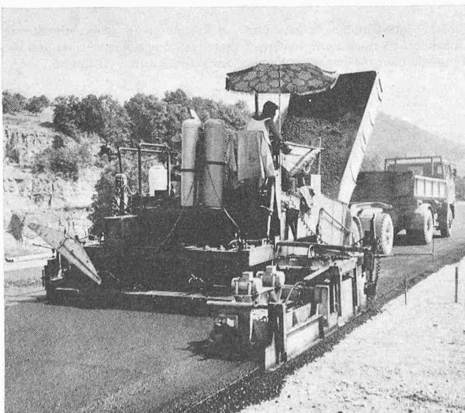
Bild 1. Elektrohydraulisch gesteuerter Fertiger im Einsatz. Im Vordergrund ist die Abtast-Steuereinrichtung sichtbar
