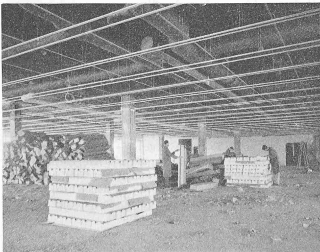
Bild 1. Unterkonstruktion der «Unipro»-Montagedecke, bestehend aus stranggepressten Aluminiumprofilen, die mit Gewindestangen an der Rohdecke aufgehängt werden
