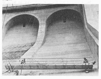
Bild 2. Sky-Climber-Arbeitsbühne im Einsatz an einem Wasserturm in Charleroi. Es mussten besondere Unterzüge konstruiert werden, um die Tragseile über die gewölbte Kuppel des Wasserturmes zu führen.
