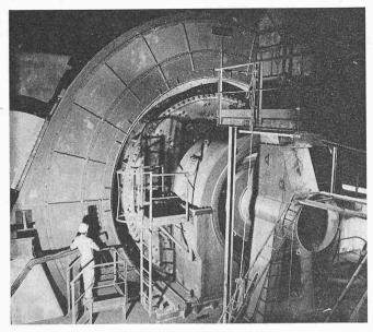
Die bisher übliche Antriebsart bestand aus Motor, Zahnkranz, Ritzel und Getriebe oder aus Motor und Getriebe mit Zahnkupplung (sog. Zentralantrieb). Die grössten Mühlen mit diesem System wiesen eine Antriebsleistung von knapp 5000 kW auf. Die AG Brown Boveri & Cie. in Baden beschritt beim Bau der Mühle für die neue Zementfabrik der Firma Ciments Lambert-Lafarge in Le Havre mit 6400 kW Antriebsleistung neue Wege<sup>1</sup>).
