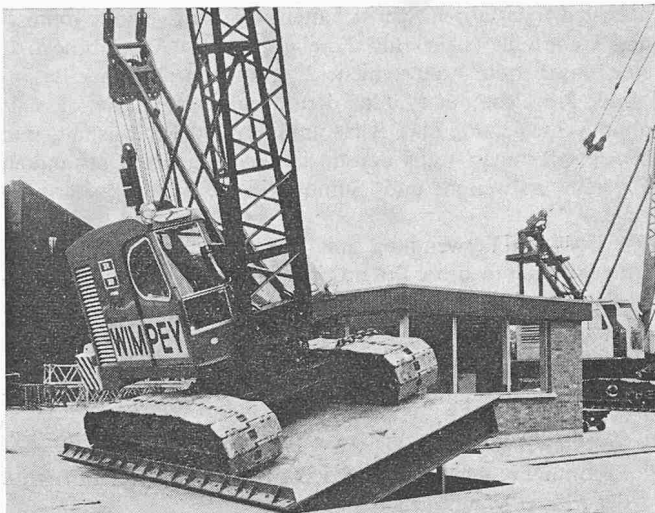
Bild 3. Prüfung eines 25-SC-Kranes auf der kippbaren Brücke zur Ermittlung der senkrechten Lage seines Schwerpunktes.
