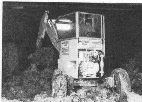
Bagger-Einsatz beim Bau einer Strassenunterführung
