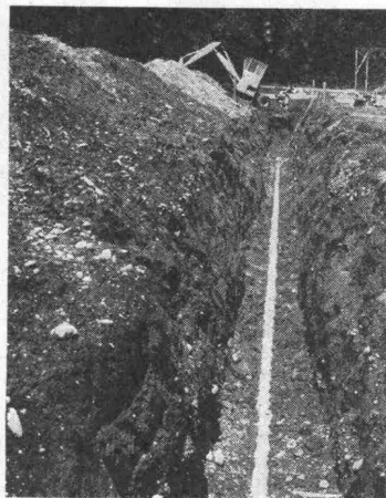
Graben für eine Rohrleitung
