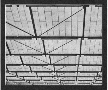
Aus schwer entflammbarem Styropor. Raumgewicht 18–20 kg/m³. Längen bis 300 cm, Breite 62,5 cm.
