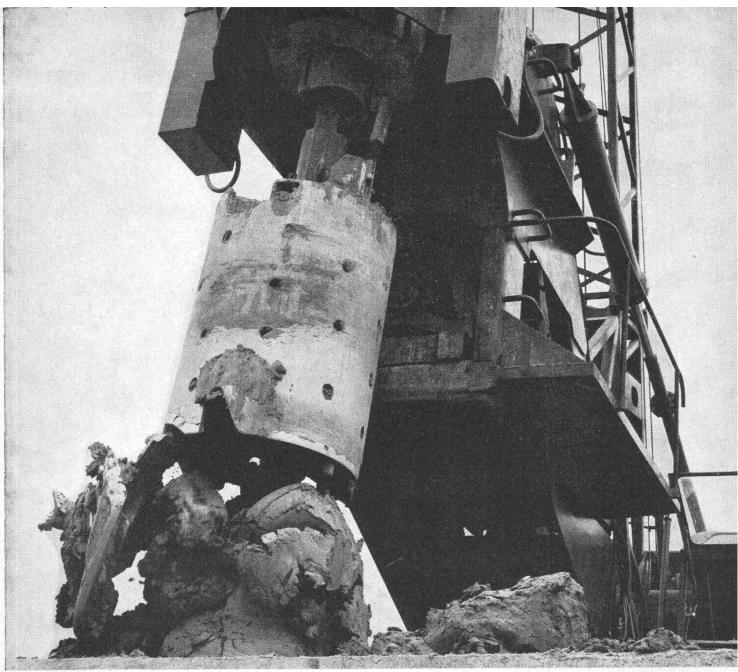
**Ortsbeton-Bohrpfähle** für Lasten von 100 bis 700 Tonnen. Bohrungen unverrohrt im Bentonitverfahren, Durchmesser 50 cm bis 150 cm, mit oder ohne glockenförmiger Fussverbreiterung zur Verminderung der Bodenpressung, mit oder ohne Schaftarmierung. Lärm- und vibrationsarm (kein Rammen).
