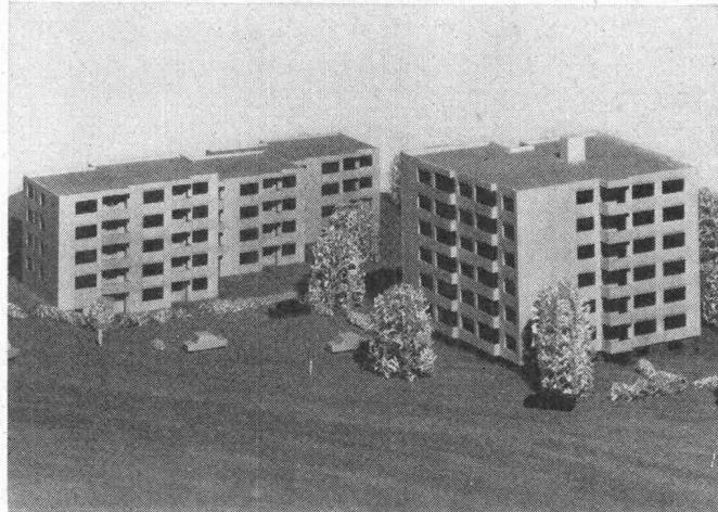
Diese Grossüberbauung wird vollelektrisch beheizt. Technische Daten: Anzahl Wohnungen: total 63; Anschlusswert der Heizanlage: ca. 580 kW; Ausrüstung: Star Unity-Nachtstrom-Wärmespeicher, Star Unity-Nieder-temperatur-Strahlungsheizung; Steuerung: vollautomatisch, aussen- und innentemperaturabhängig.
