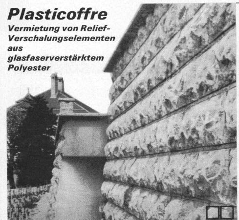
Die ideale Lösung für den Bau von Betonmauern in perfekter Naturstein-Nachahmung
