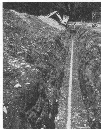
Graben für eine Rohrleitung
