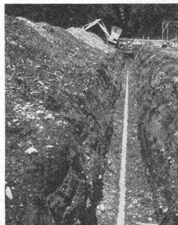
Graben für eine Rohrleitung
