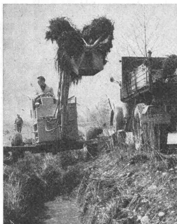
Arbeit mit dem Grabenlöffel
