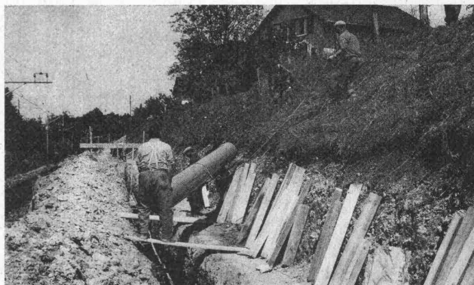
KALIDUR-Kanalisationsrohre, verlegt im Bahneinschnitt
