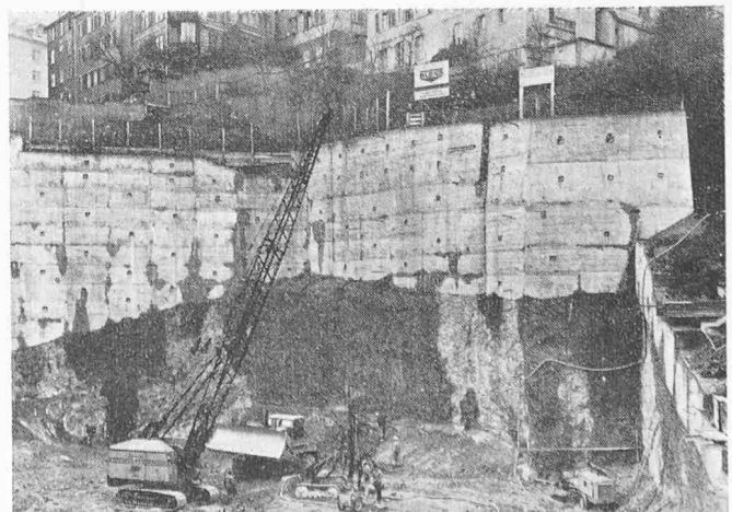
Bild 7. Teilweise permanent verankerte Baugrubenwand in St. Gallen. Im unteren Teil reichen die Anker bis in den anstehenden Felsen
