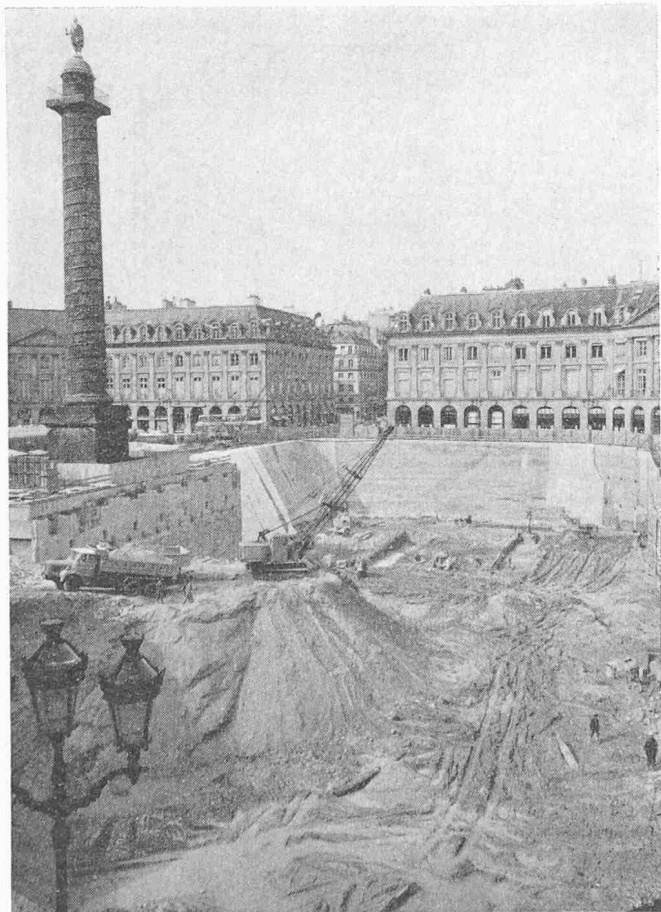
Bild 6. Baugrube für unterirdische Parkgarage Place Vendôme in Paris. Sicherung eines historisch bedeutungsvollen Bauwerkes mittels einer verankerten, partiellen Baugrubenwand
