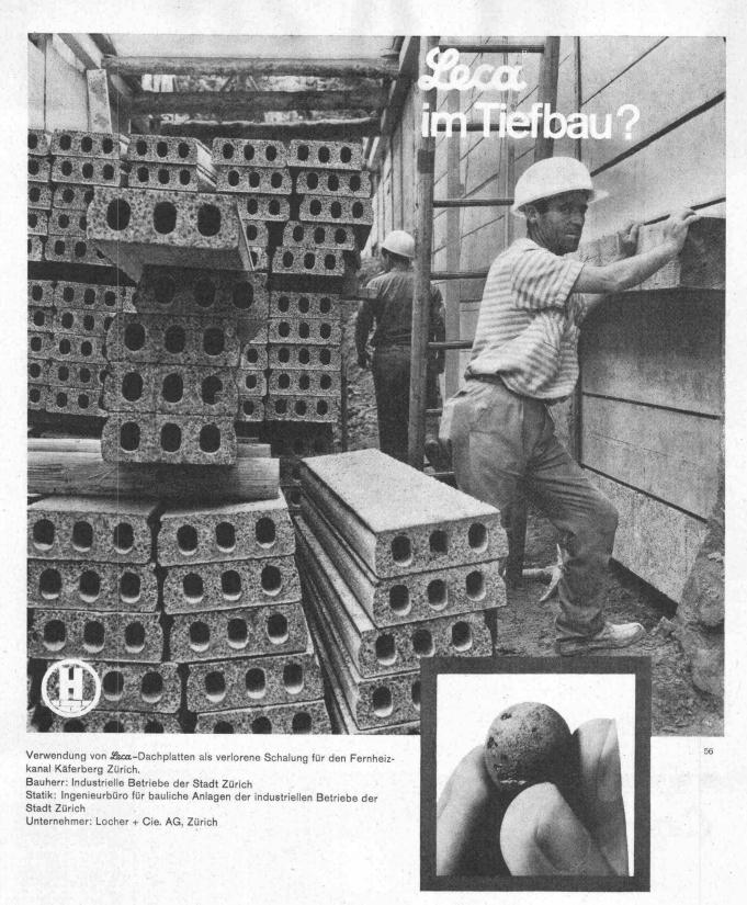
&ωca-Dachplatten sind eigentlich für den Hochbau – als Dachhautträger oder für Zwischenböden – bestimmt. Geringes Eigengewicht, hohe statische Belastbarkeit, gute Wärmedämmung und ausgewiesene Widerstandsfähigkeit gegen Wasser und Feuer zeichnen die Platten aus.
