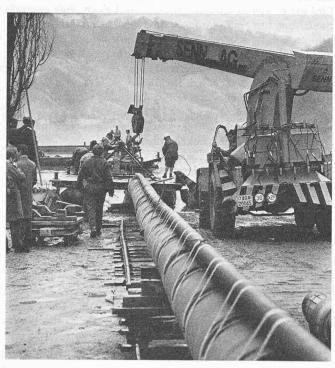
Bild 11. Verlegung des Rheindükers Eglisau. Rohrende mit Abschlussplatte, Verlattung, Zementrohr als Ballast und Zusatzrohr für Kabel (Photo Comet)
