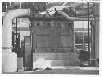
von 7000 Nm3/h zu erbringen. Das Kohlengas ist auf einen Druck von 25 atü zu verdichten. Diese Funktionen übernimmt ein Hochdruckkompressor. Sobald der Netzdruck unter einen bestimmten Wert absinkt, wird der Kompressor in Betrieb gesetzt. Die hohen Betriebskosten für den elektrischen Antrieb werden in Kauf genommen, da ein Betrieb nur für wenige Stunden oder Tage zu erwarten ist.
