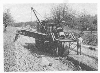
Bild 28. Grabenaushub mit Grabenbagger
