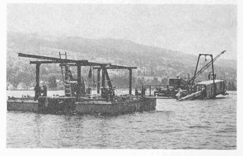
Rampe voraus, d. h. die Rohrtangente musste mit der Rampenneigung von der untersten Auflagerolle bis zur Arbeitsstelle der Schweisser zusammenfallen. Die Leitung muss sich ausserdem auf den Ablaufrollen stets frei in der Längsrichtung bewegen können. Die gegenseitige Abhängigkeit dieser «ideellen» Rampenneigung, der Wassertiefe und des Seegrundgefälles und folglich die je nach den herrschenden Verhältnissen einzustellende Neigung der Ablaufbahn wurden rechnerisch ermittelt.
