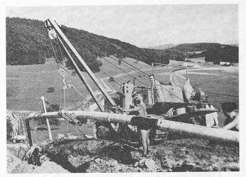
Bild 29. Isolationskontrolle der Leitung
