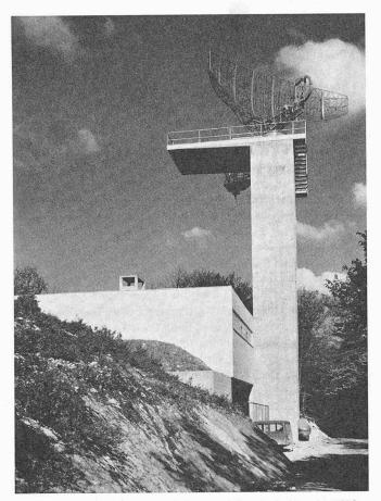
Bild 3. Langdistanzradaranlage «Lägern». Grösste Reichweite 350 km
