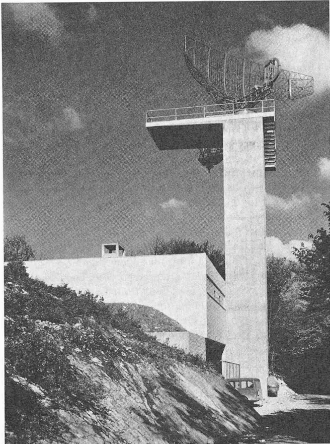
Bild 3. Langdistanzradaranlage «Lägern». Grösste Reichweite 350 km
