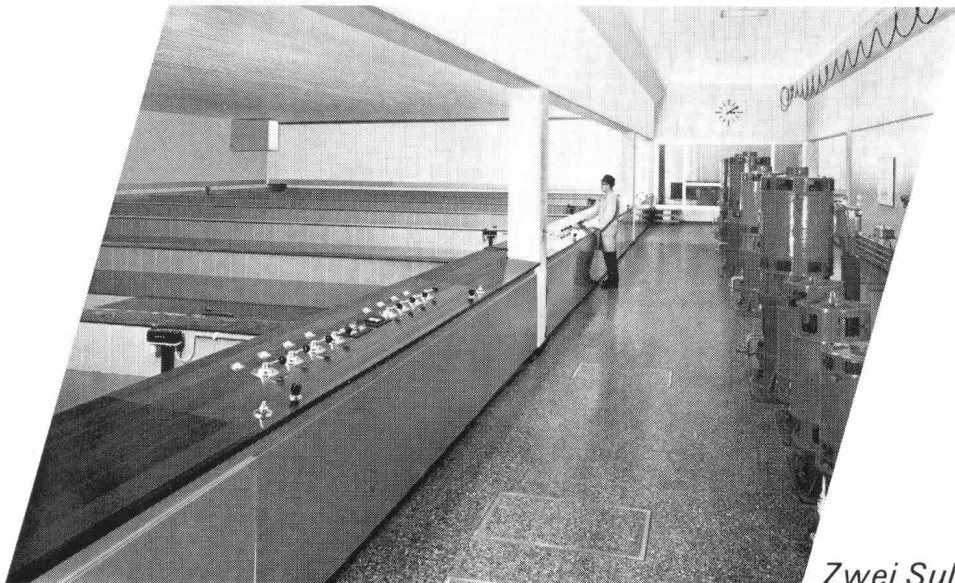
▲ Schnellfilteranlage «Champ-Bougin» der Stadt Neuenburg für das Aufbereiten von Seewasser zu Trinkwasser. Leistung 1800 m 3 /h
